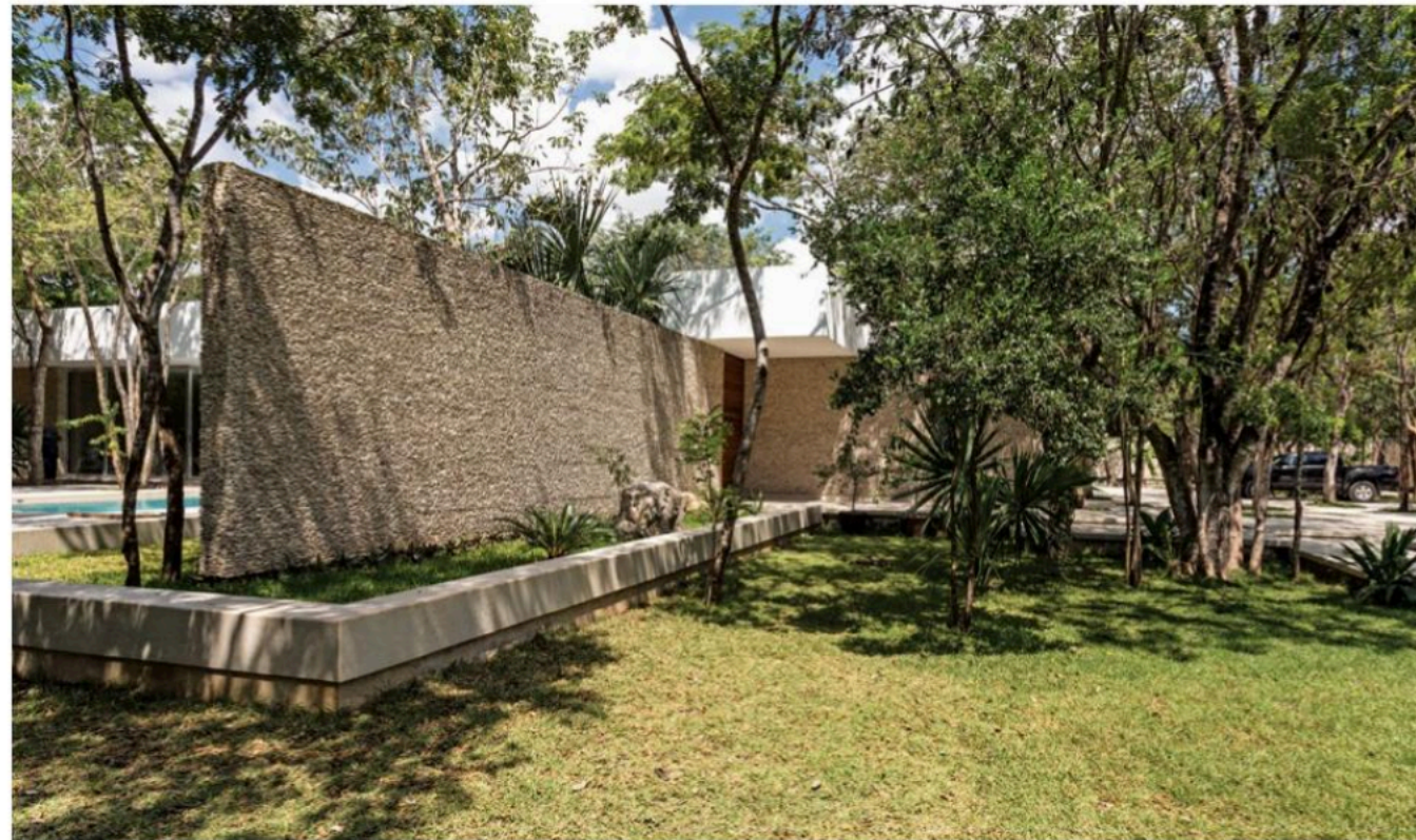
Recubrimiento de piedra de cantera tipo rajuela. Rajuela, local technique of stone work.
